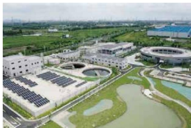
命周期内节约标准煤约3680吨，每年减排二氧化碳880吨。此项目的投用标志着无锡市惠山区正式开启了“污水治理+光伏发电”环境治理基础设施项目建设新模式。该工程大面积水池全部采用封闭式建设，且周边空旷、光照充足，为加装太阳能光伏板创造了得天独厚的空间条件，不仅可以集约化用地，光伏板还能够遮挡直射水池的阳光，有效抑制池内藻类生长。同时，污水处理厂需24小时连续运转，是“耗能大户”，光伏电站所发电量能较好地被污水处理厂用电负荷消纳，一定程度上实现了自发自用、自给自足。
