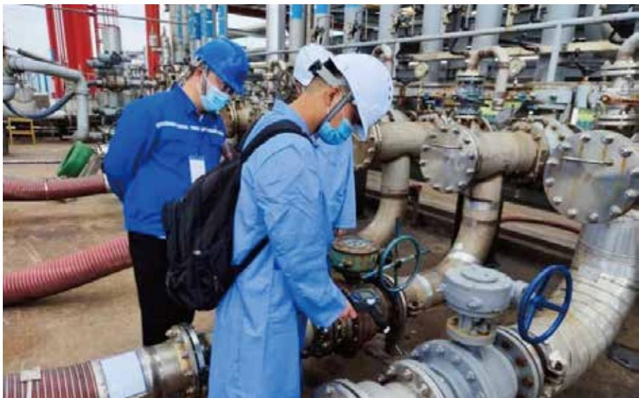
三是精准锁定泄漏源头，大幅削减异戊烷排放。针对园区异戊烷高值，综合运用气象分析、溯源模拟，定位到仓储物流企业油品储运环节排放问题。园区组织对仓储物流企业进行全面摸排，运用红外成像仪等设备锁定排放源头，推动相关企业在确保安全的前提下对阀门、法兰实施改造，储罐更换高效呼吸阀，新建油气回收装置。改造完成后，储罐顶部 VOCs 浓度值降低 90% 以上，园区异戊烷浓度同比改善 43%。
